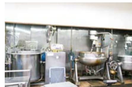
本社製造工場内部
